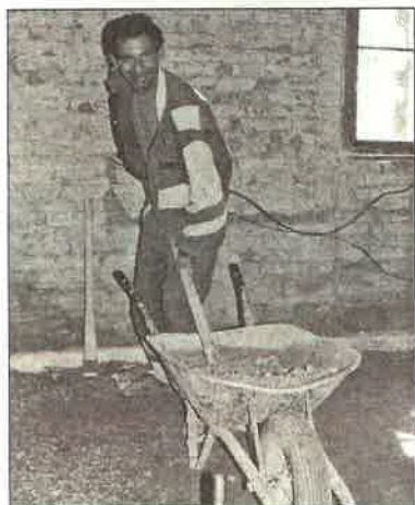
Stavební firma momentálně pracuje na podlahách v přízemí fary. Foto -peg-
